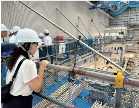
11/9 副委員長を務める建築都市委員会の視察。 首里城の復旧工事の説明を受けました。
